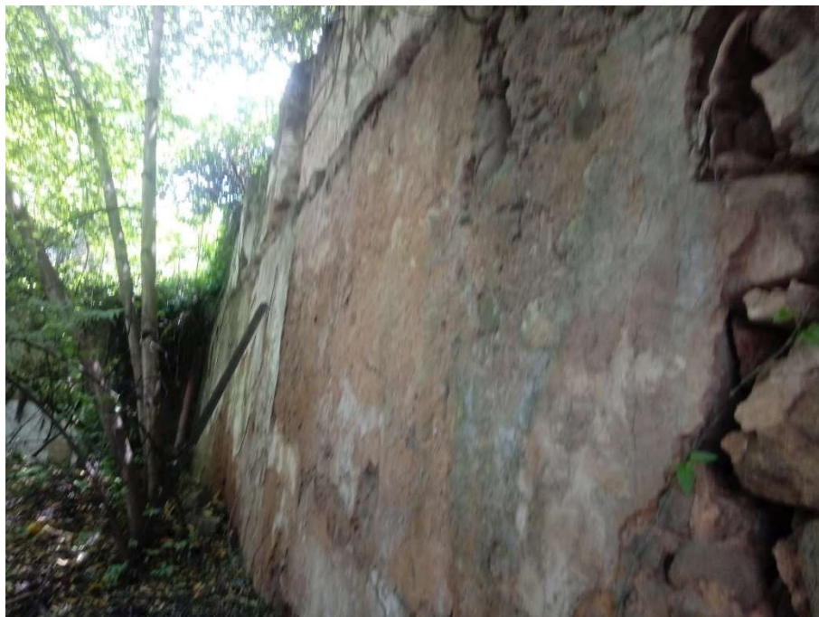
Imagem 9 – Rachaduras/Fendas/Brechas de grandes proporções na estrutura de arrimo
