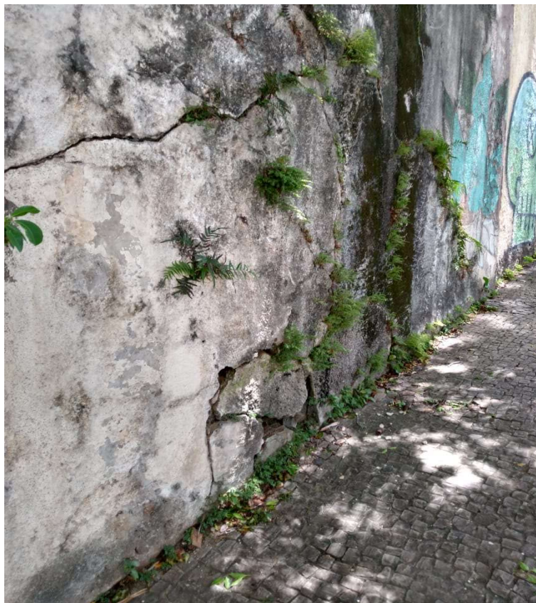
Imagem 7 – Detalhe das rachaduras na parte inferior (base do muro)
